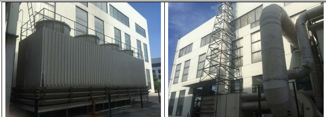
图 4.1-8 酸性废气防治设备及其排气筒（5#）照片
