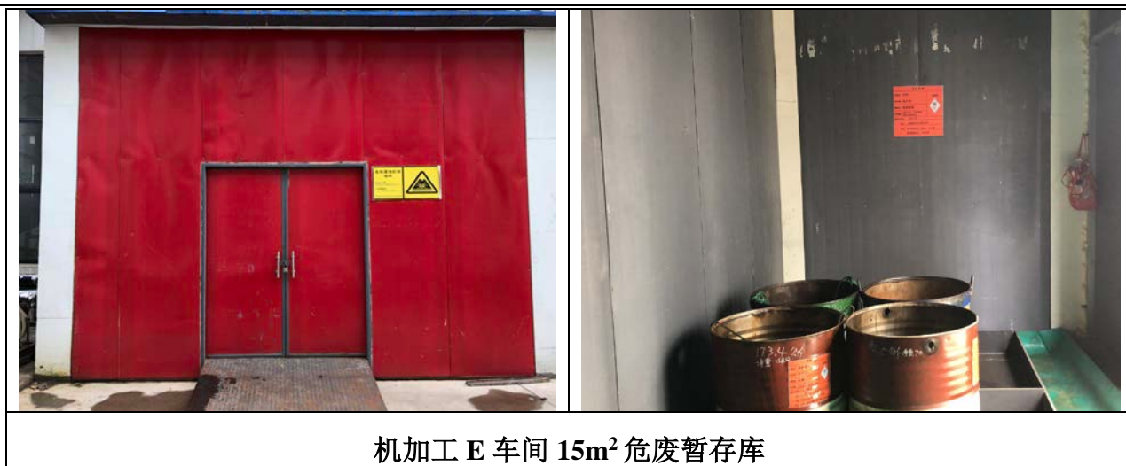
图 4.1-10 危险废物暂存库现场照片
