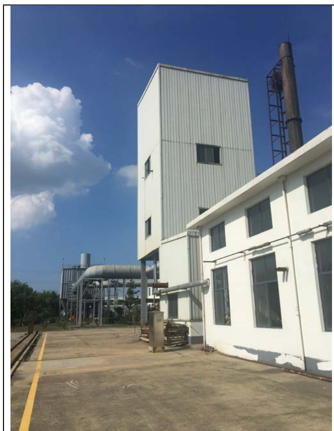
图 4.1-4 蒸汽锅炉废气排气筒（2#）照片
