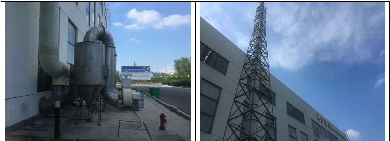
图 4.1-6 表面抛光粉尘除尘器及其排气筒（4#）照片
